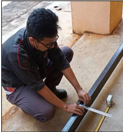
Rajah 3.4 Proses mengukur dan menanda pada besi mengikut dimensi
