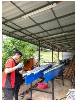
Rajah 3.17: Proses penampalan penutup pada pelampung
