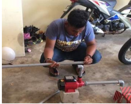
Rajah 3.9 proses pemasangan
