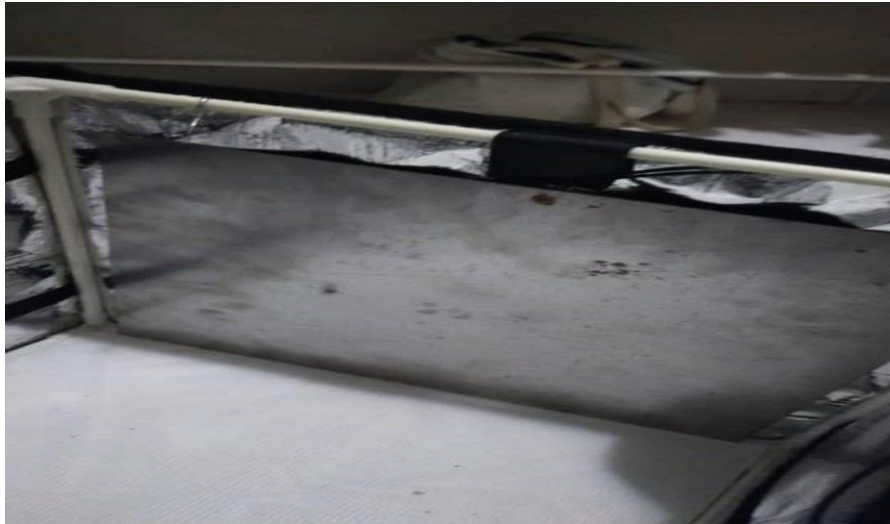
Rajah 3.10 Menebuk dan memasang plat besi
