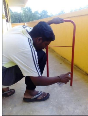
Rajah 3.8 Kerja kemasan
