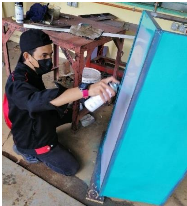
Rajah 3.8.4 Proses pemasangan
